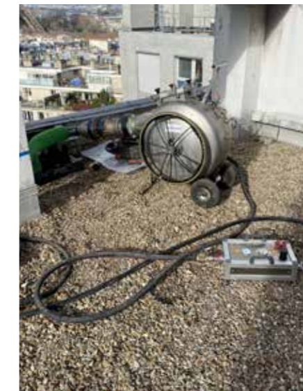
Kontrolle während der Inversion mit der BRAWO® Control Box
