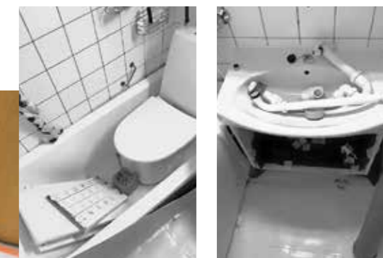
Bild 7: Abdecken des Hausflures und Abmontieren der Entwässerungsgegenstände
