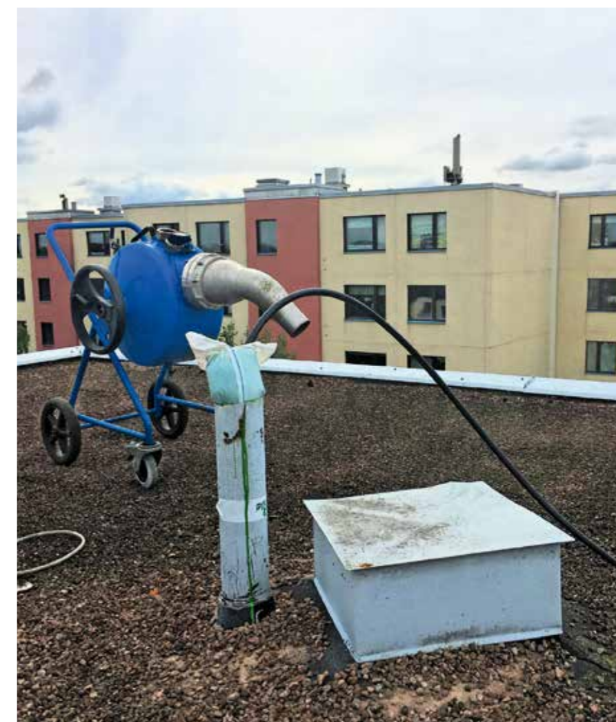
Bild 10: BRAWOLINER®-Inversion einer Falleitung vom Dach in den Keller
