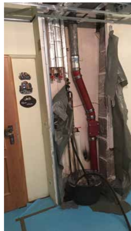
Neu hergestellte Revisionsöffnungen in einigen Zwischenebenen der Ferienwohnanlage
