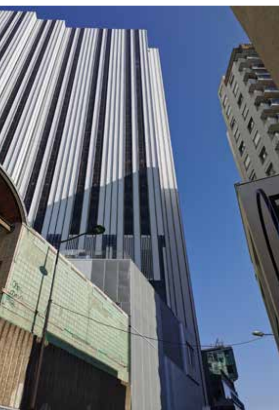
Hotelturm mit 32 Stockwerken 24 | BRAWO® SYSTEMS Referenzbroschüre
