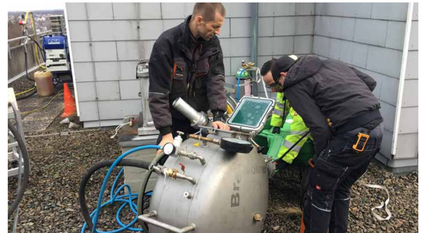
Inversion des Schlauchliners vom Dach
