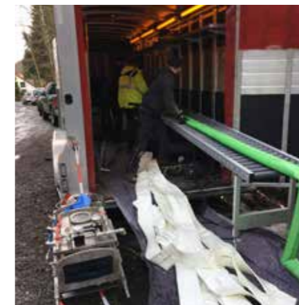
Tränkung des BRAWOLINER® HT (DN 125) auf der Baustelle
