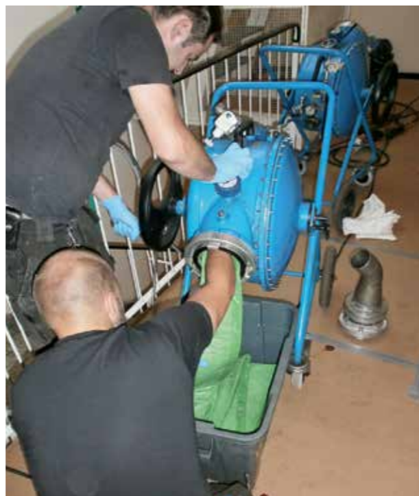
Bild 11: Liner-Inversion im Nennweitenbereich DN 50 bis DN 70 mit einer „Linerkanone“
