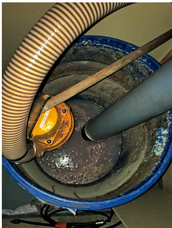
Bild 8 und 8a: Auffangen der Feststoffe beim Reinigen der Entwässerungssysteme
