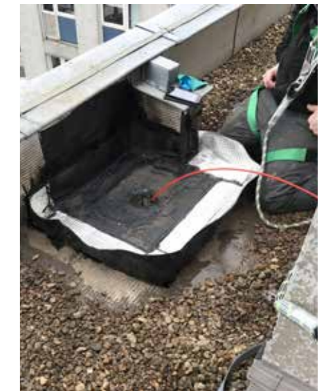
Zugang zur Abwasser-Falleitung
