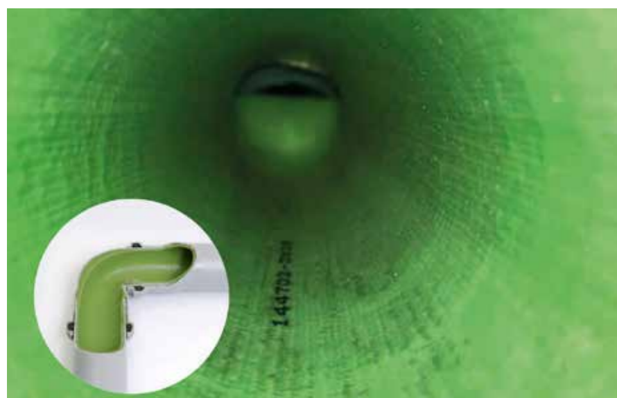
BRAWOLINER®-Rohrsanierung DN 50
