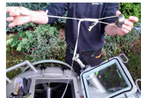
Die Stahlkappe ermöglicht die Entkopplung des LED-Kopfes MEGA am Linerende
