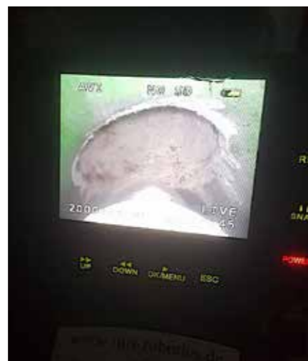
Mit Fräsroboter geöffneter Zulauf DN 100 aus einem DN 125er Fallstrang heraus
