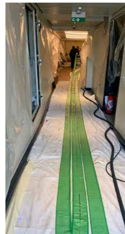
Imprägnieren der 70 Meter langen BRAWOLINER®
