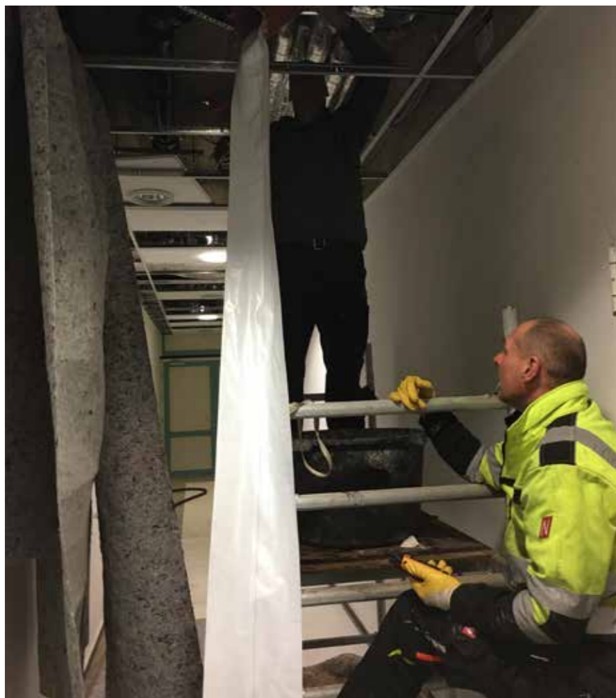
Schlauchliner am Inversionsende im unteren Stockwerk angekommen
