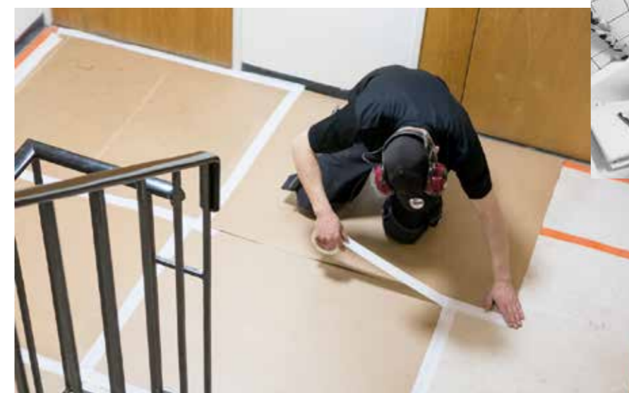
Bild 7: Abdecken des Hausflures und Abmontieren der Entwässerungsgegenstände
