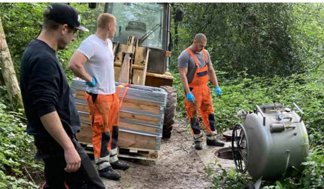
Kurz vorm Einbau: Vorbereitung der Installation des BRAWOLINER®
