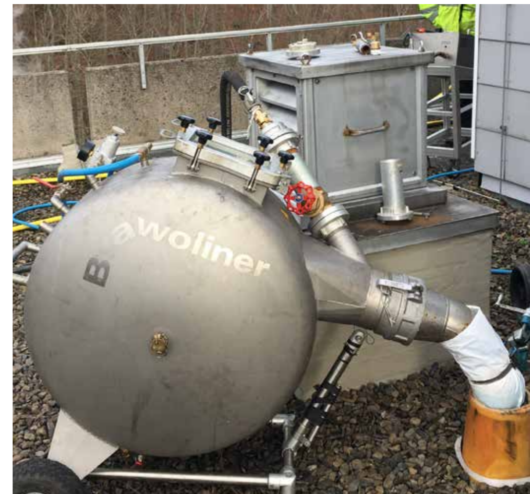
Dampfhärtung des Schlauchliners
