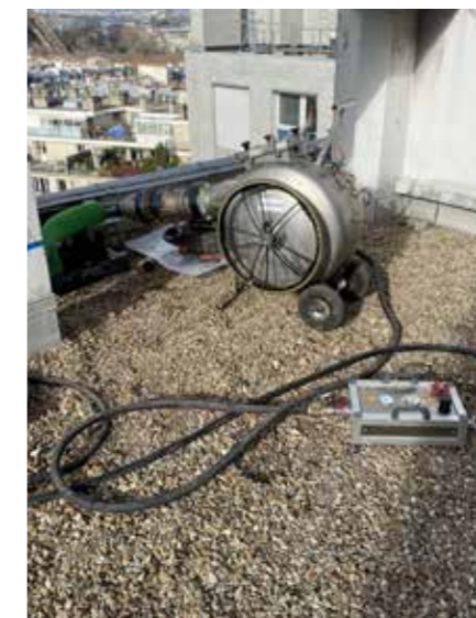
Photo 3 : Contrôle pendant l'inversion avec le BRAWO® Control Box
