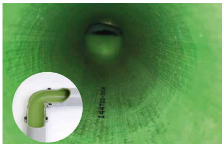
Réhabilitation de tuyaux BRAWOLINER®
