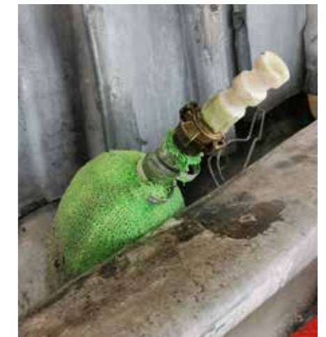
Le durcissement à la vapeur effectué à l'aide du manchon de sortie de vapeur
