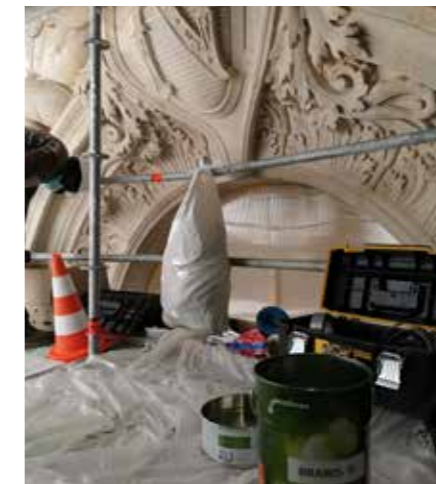
Le chantier au Tribunal de Commerce, Paris
