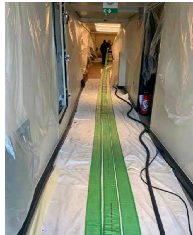
Imprégnation du BRAWOLINER® de 70 mètres de long
