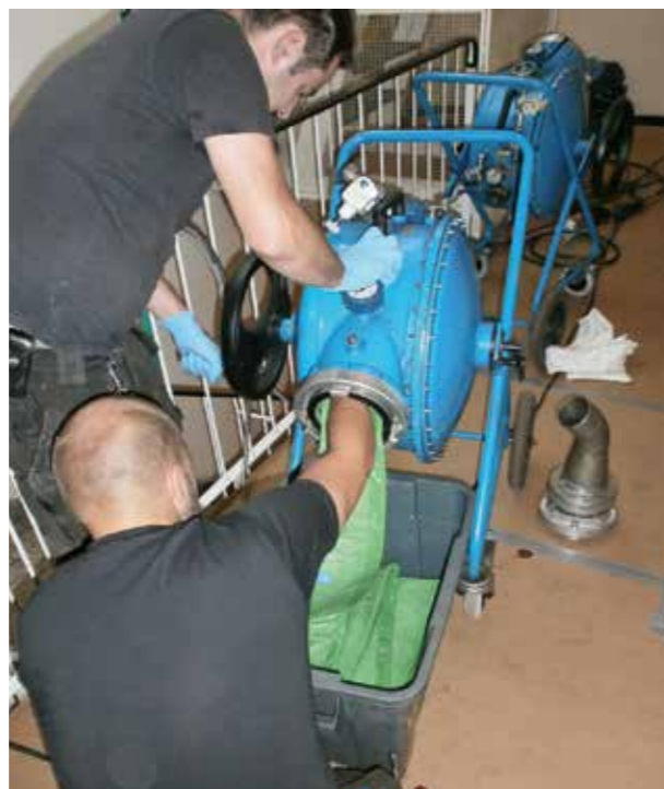
Photo 11 : Inversion de la garniture d'étanchéité avec un « canon à garniture d'étanchéité », pour des largeurs nominales comprises entre DN 50 et DN 70
