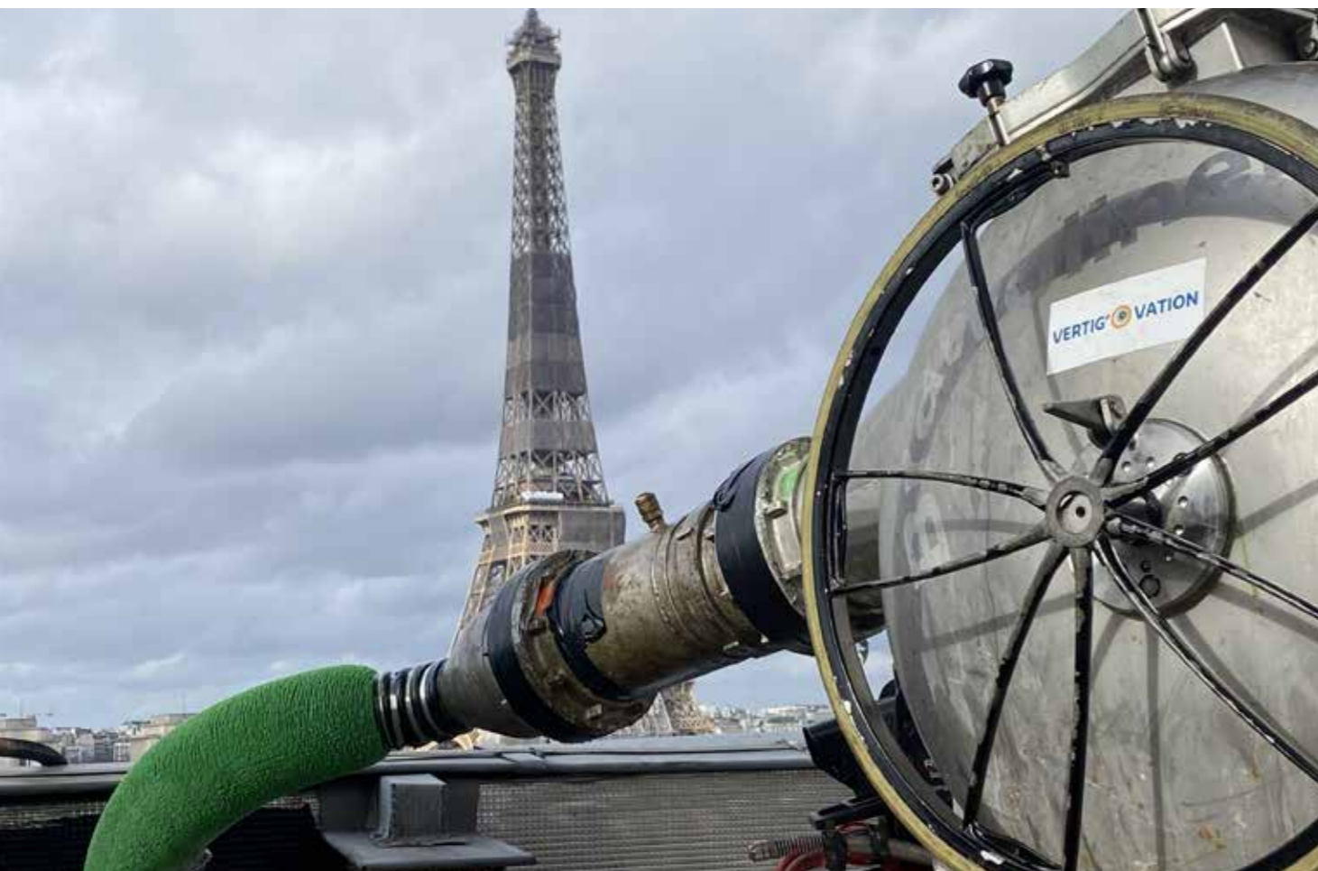
Photo 1 : Vue merveilleuse sur la Tour Eiffel lors de l'installation du BRAWOLINER® HT DN 100
