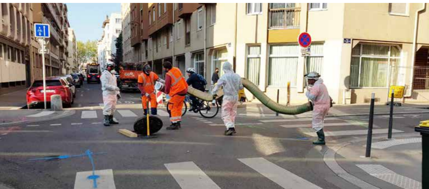
Le BRAWOLINER® imprégné (dans le tuyau flexible en plastique) en route vers le raccordement souterrain dans l'égout principal accessible.
