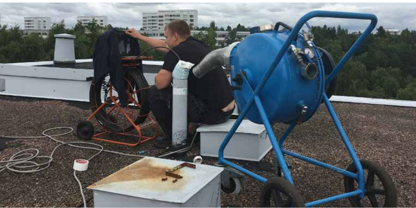
Photo 1 : Assainissement BRAWOLINER® de descentes sur les toits d'Helsinki
