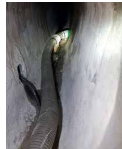
Tuyau en plastique flexible dans le tuyau principal pendant le retournement du BRAWOLINER®
