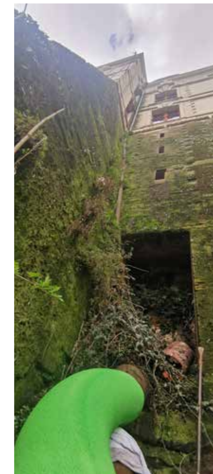
Installation dans des conditions très difficiles
