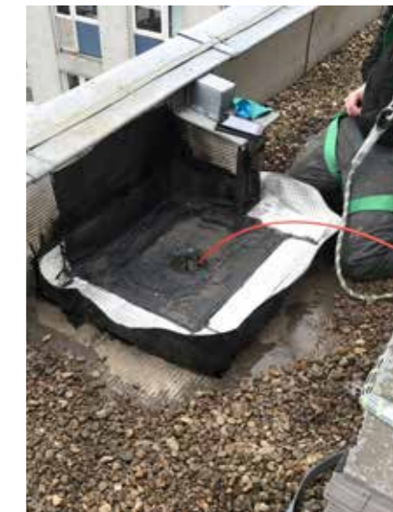
Photo 5 : Accès au tuyau de descente des eaux usées
