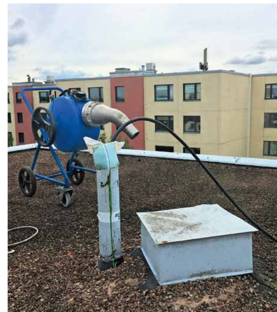
Photo 10 : BRAWOLINER® inverse une descente du toit au sous-sol
