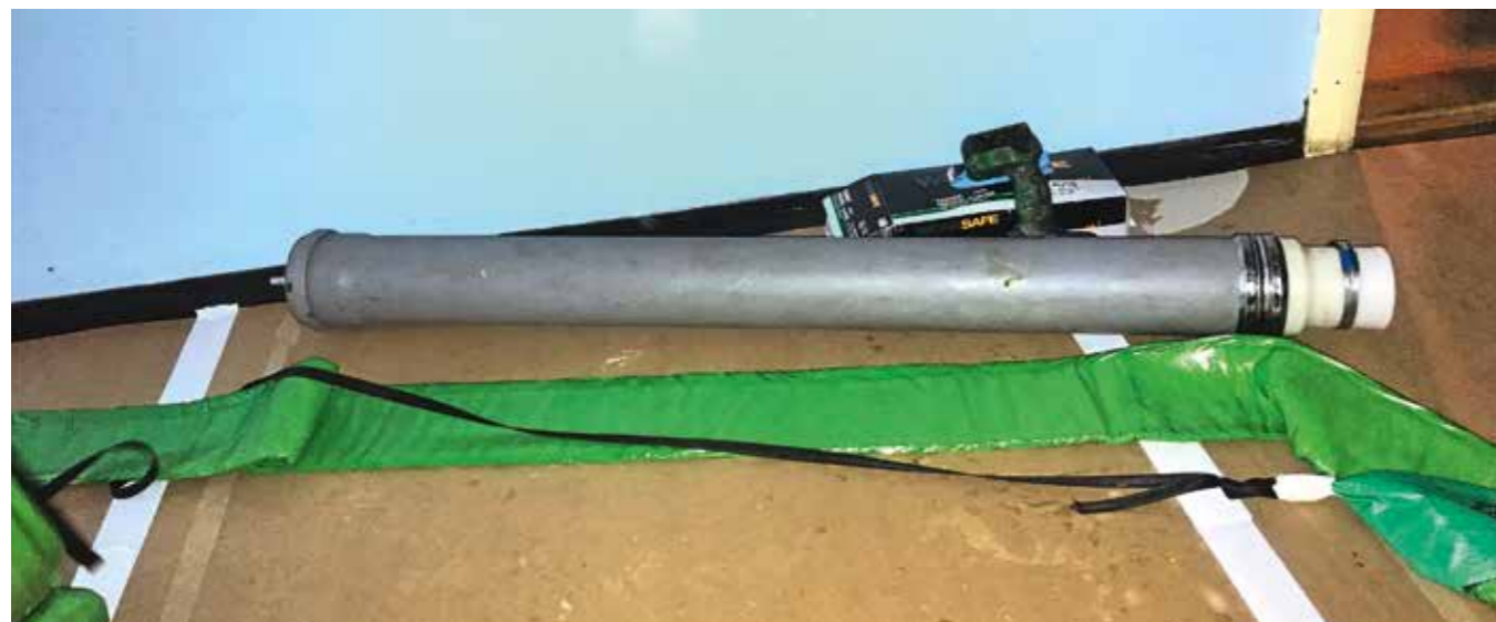
Photo 11 : Inversion de la garniture d'étanchéité avec un « canon à garniture d'étanchéité », pour des largeurs nominales comprises entre DN 50 et DN 70
