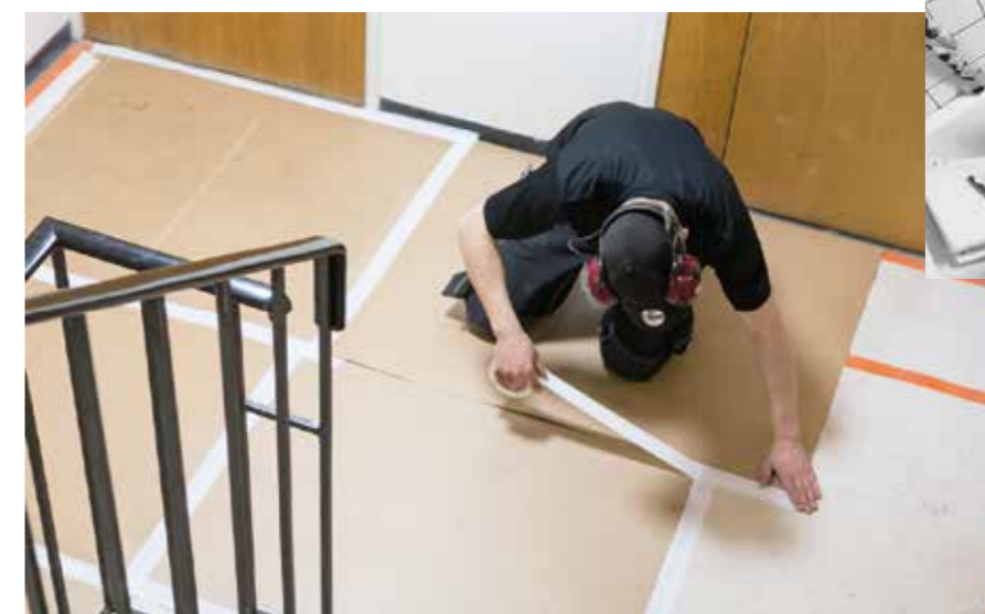
Photo 7 : Les couloirs sont recouverts, les objets à évacuation d'eaux usées sont démontés
