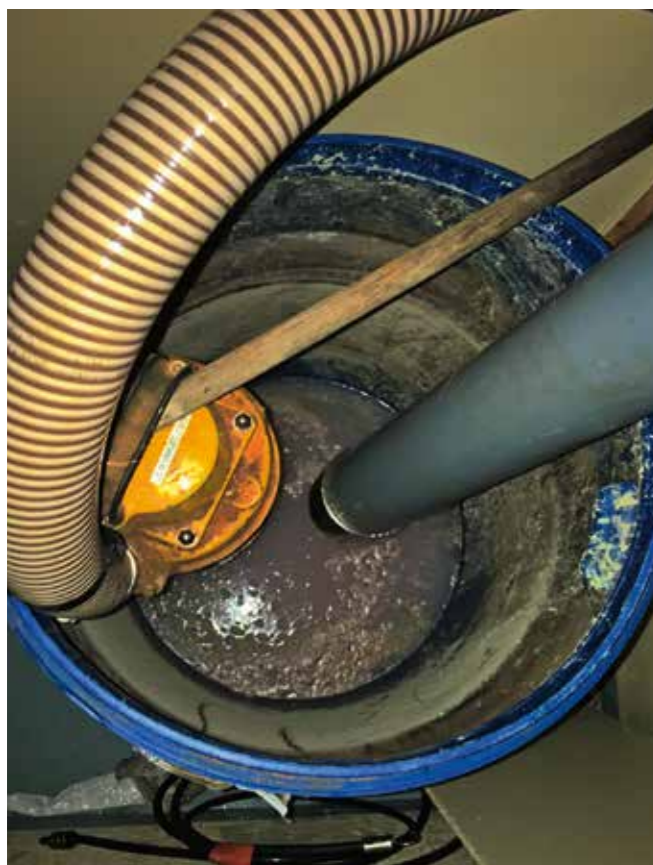
Photo 8 et Photo 8a : Recueil des solides lors du nettoyage des systèmes de drainage
