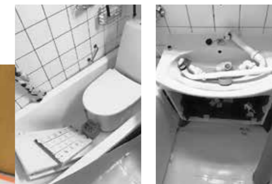
Photo 7 : Les couloirs sont recouverts, les objets à évacuation d'eaux usées sont démontés
