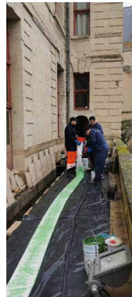
Préparation de la BRAWOLINER®
