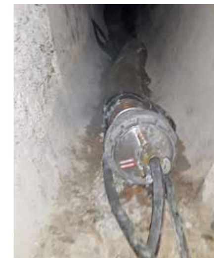
Raccordement de la vapeur à l'extrémité du tuyau en plastique
